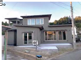
建築工事直後
