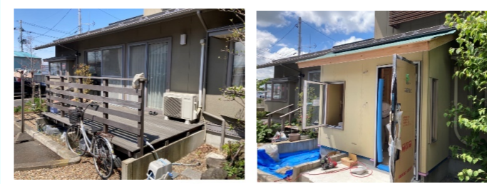
工事前 → 工事中
