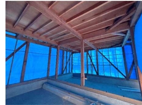
解体工事が進みスケルトンに。すべて完了したら、基礎工事と大工工事に入っていきます。
