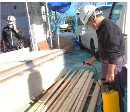
通気胴縁に防蟻剤を吹き付けている様子です。中では電気配線工事が完了しました！
