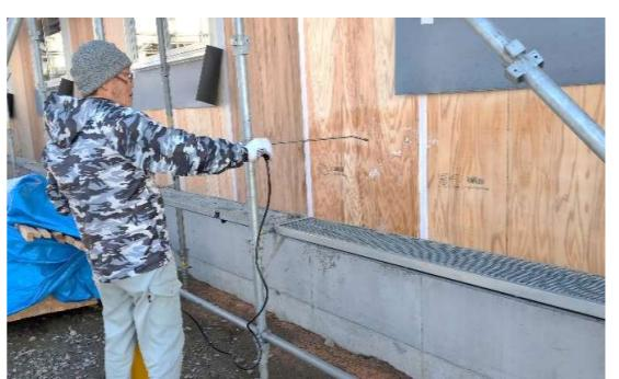
外周部の構造用合板に防蟻剤を吹き付けている様子です。地面から1mの高さまで、しっかりシロアリ対策をしています！
