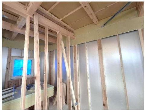
外張り断熱+充填断熱のお家で、室内側に断熱材が張られました。
