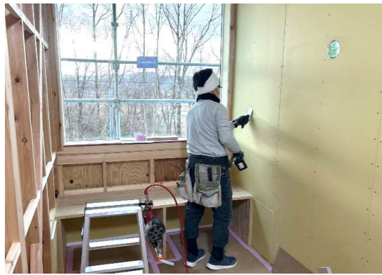
内装屋さん石膏ボードのパテ処理をして、これからクロスが貼られていきます！
