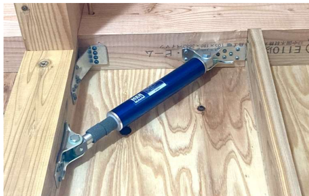
お施主様のご要望で、日本制震システムさんの制震ダンパーを取り付けました！
