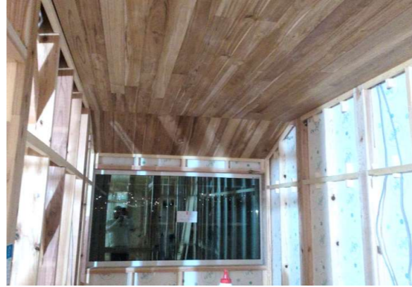
床と木板張り部分の天井が貼られ、壁には石膏ボードを貼り始めました！
