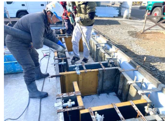
基礎の立ち上がりの打設をしました！これから養生をし、脱型します。
