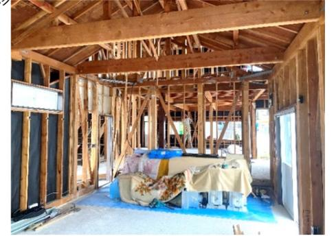
築33年。事務所併用の住宅をスケルトンの状態まで解体して、2世帯住宅へと間取りも大きく変える大規模な断熱改修工事がスタートしました。
