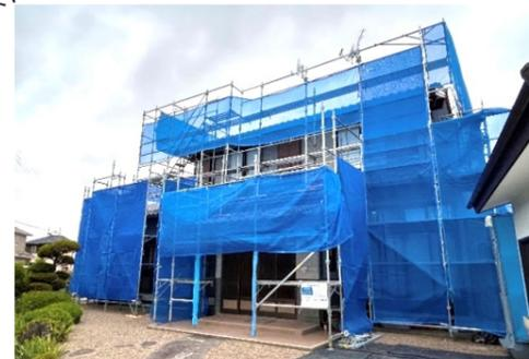
築41年の広い縁側のある日本家屋です。既存の瓦屋根を解体して軽い屋根材に葺き替え太陽光パネルを設置します。そして、1階の断熱改修工事に進んでいきます。
