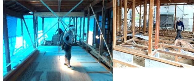
築47年の住宅の1階を全スケルトン、2階は内側のみスケルトンに。床下や外壁周りに断熱材を組み込み、下地合板の施工などを行っています。
