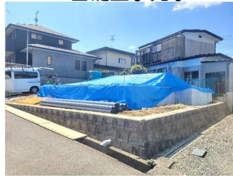
基礎工事が完了しました！木工時スタートまでしっかり養生をして、外回りの配管工事などを進めています。
