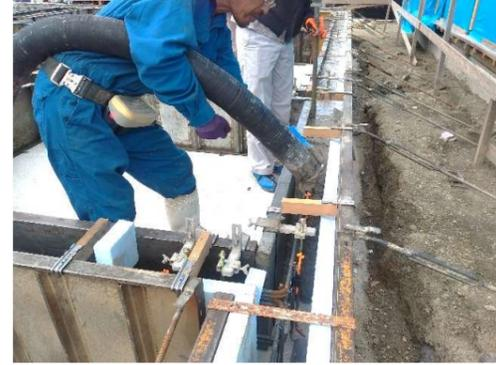
配筋が終わり、型枠にコンクリートを流し込んでいきます。
