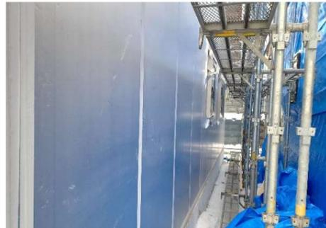
外部の断熱施工が終わり、これから透湿防水シートを張っていきます！
