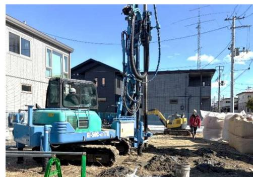
地盤が弱いため、始めに地盤補強を行って強い地盤にします！
