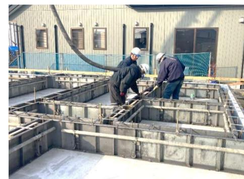
基礎の立ち上がり部分の型枠の中にコンクリートを打設しています！
