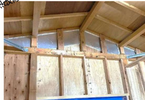
外周部の壁の内側に断熱材を張り、
