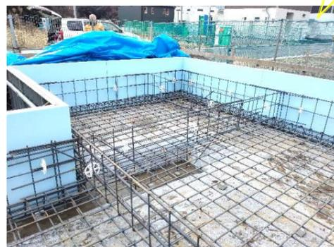
基礎の外側には断熱材が組み込まれています！
